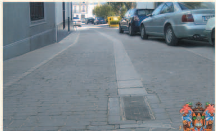
Después de obra
