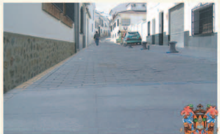
Después de obra
