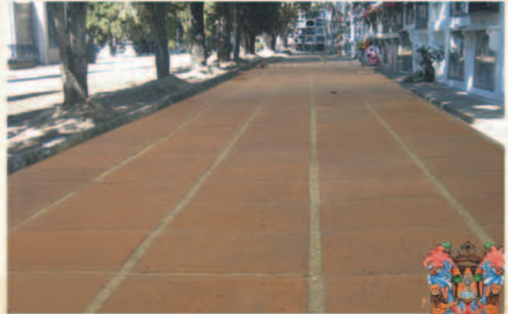
Después de obra
