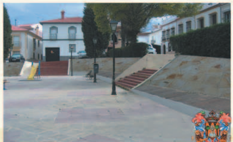
Después de obra
