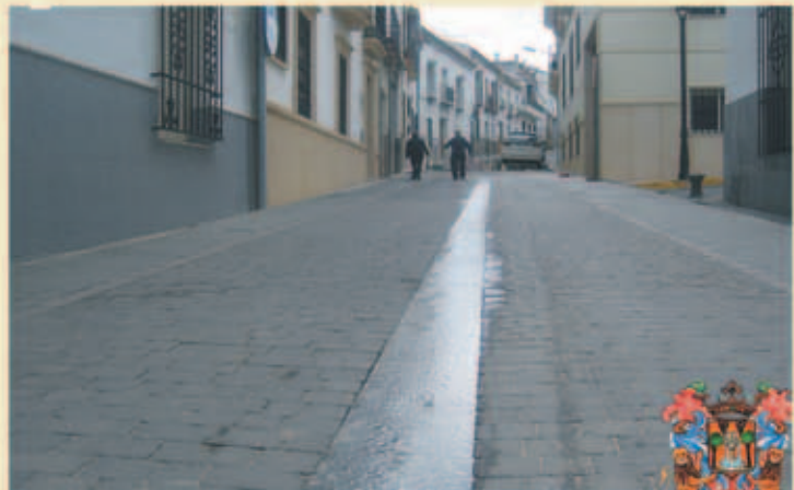
Después de obra
