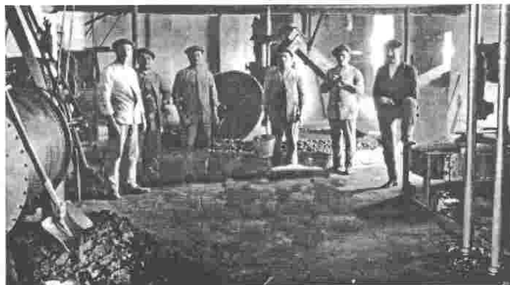
Fte: Foto reproducción de la original, facilitada por los propietarios.
