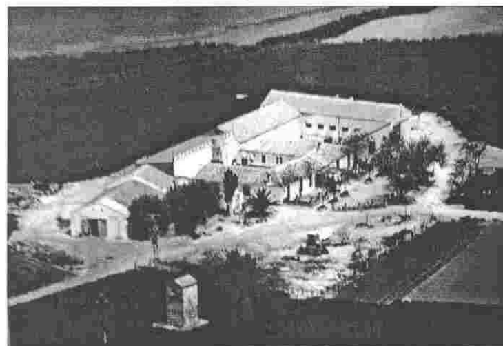
Fte: Foto tomada de una original en el interior del edificio.
