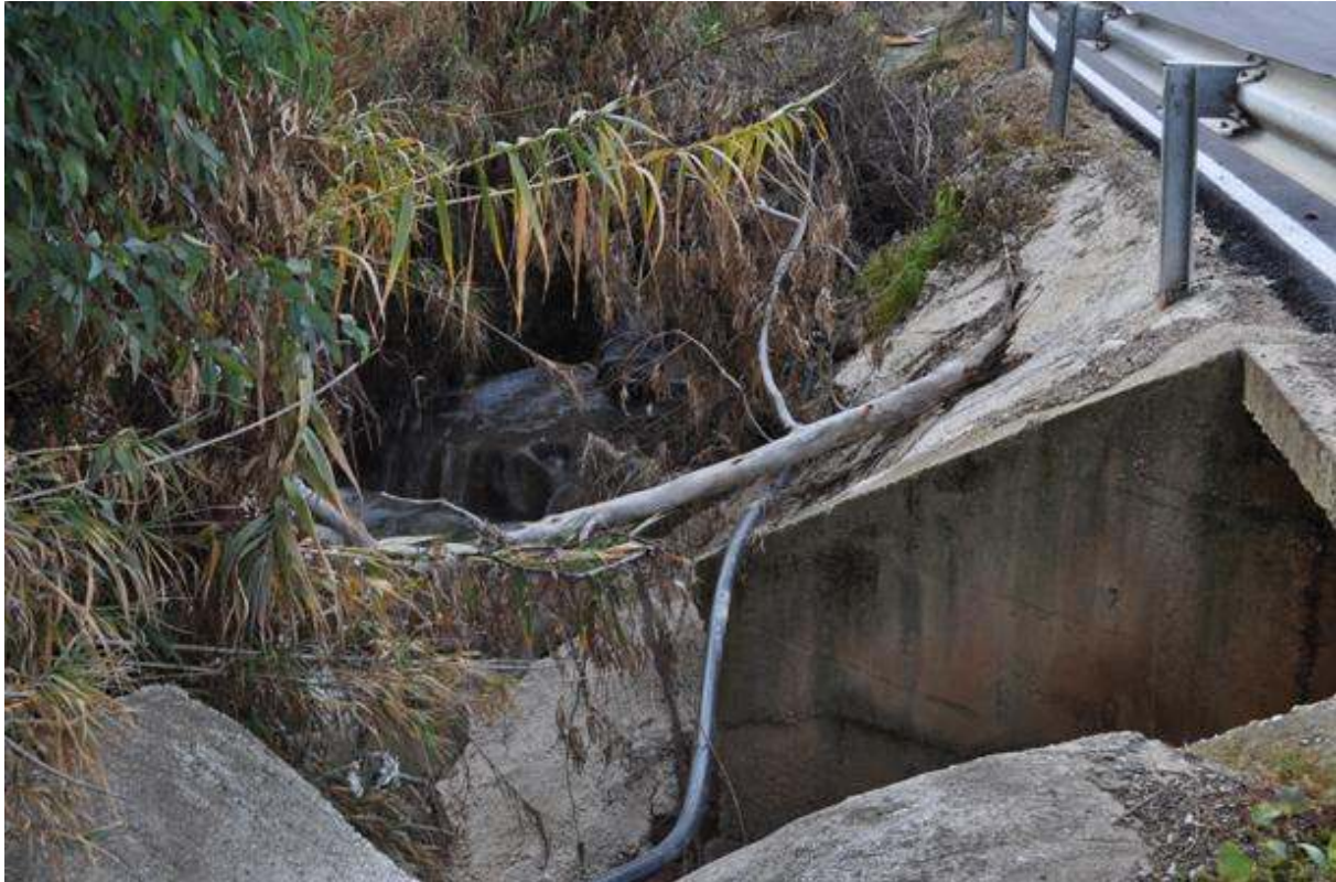
Ilustración 5: Punto de vertido de aguas residuales en Arroyo de las Monjas-Carretera de Fernán-Nuñez
